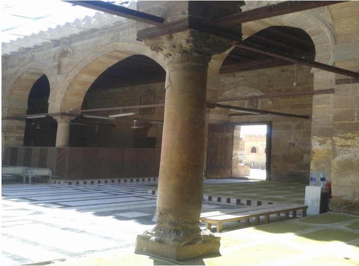
(لوحة ٢) توضح العقود يعلوها مدماك للتخفيف عن الأعمده ويظهر بها عمود تم استخدام التاج كقاعده
